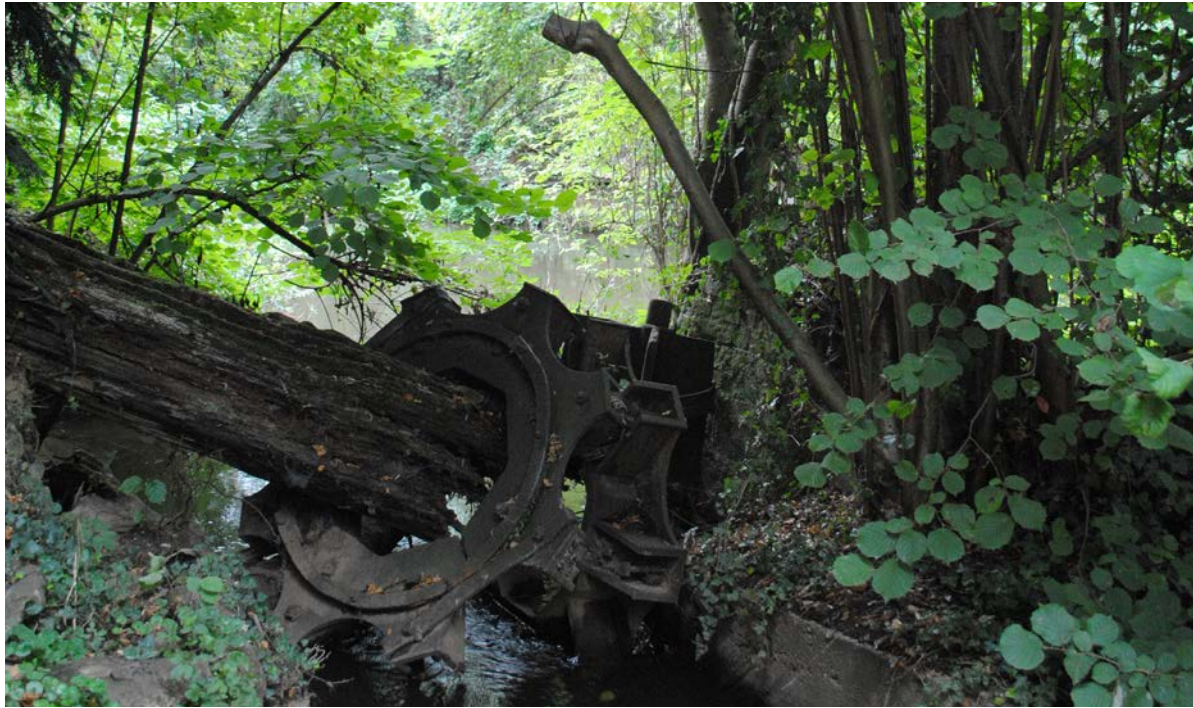
Wasserradwelle Paffendorfer Mühle | © Schmid (LVR), 2016
