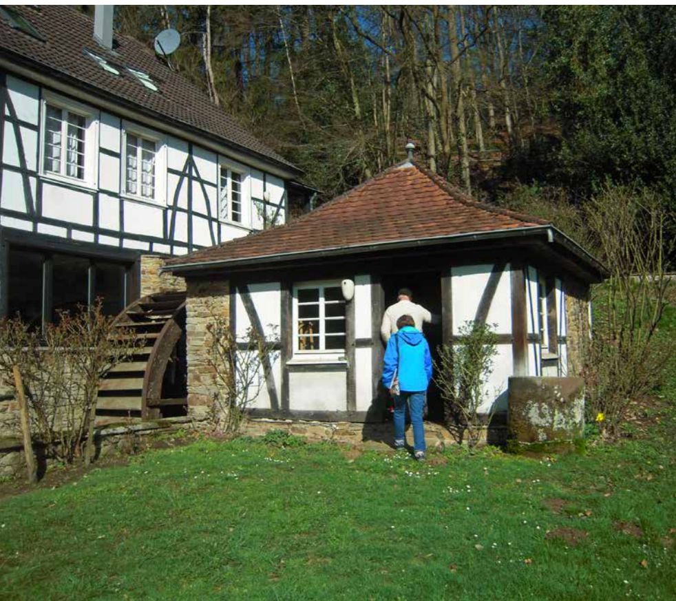
Besichtigung der ehemaligen Schleifmühle Ernekotten bei der Mühlenaufnahme 2019 vor Ort am Itterbach in Haan.
