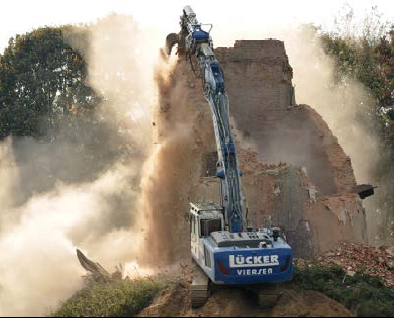
Abriss der Immerrather Mühle. Foto: Elmar Aretz, 2018.
