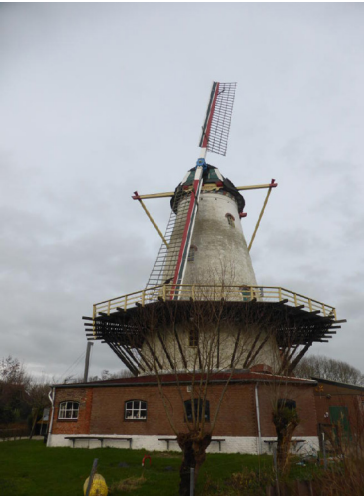
Die Mühle „De Graanhalm“ in Burgh-Hamstede, Zeeland (NL), wartet Anfang Januar 2018 auf die Neuinstallation der Innenrute. Die nicht entfernte Außenrute ist durchgehend und nicht teilbar. © Ralf Kreiner 2018.
