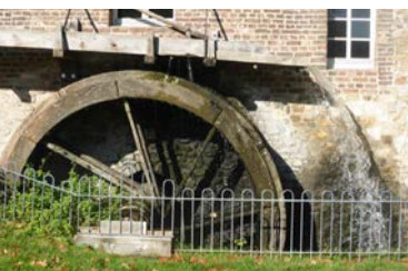
Das nicht mehr funktionsfähige ober-schlächtere Wasserrad der Welschen Mühle, Aachen, © Ralf Kreiner 2017.
