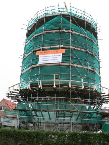
Die eingerüstete Mühle „De Noormann“ in Westkapelle (Zeeland, NL) ohne Haube und Flügel, 5. Januar 2013, © Ralf Kreiner 2013.
