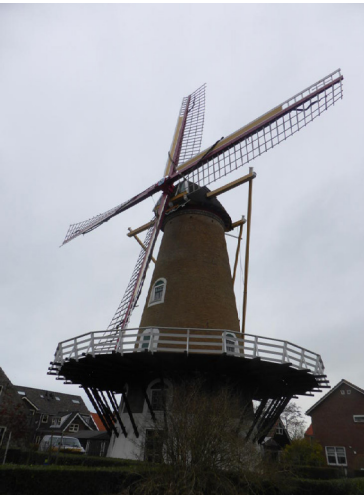
Die restaurierte Mühle „De Noormann“ in Westkapelle (Zeeland, NL). Die Flanschverbindung zwischen den Hälften der Flügelruten sieht man nicht, da sie sich im eisernen Achskopf verbergen, 5. Januar 2016, © Ralf Kreiner 2016.
