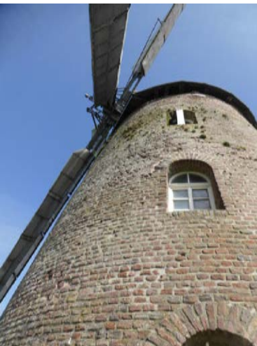
Bilau-Flügel der Stommelner Windmühle, Pulheim (Rhein-Erft-Kreis), © Ralf Kreiner 2017.
