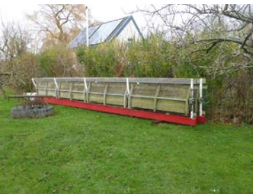
Die 2017 ausgebaute geteilte Rute der Mühle ‚De Graanhalm‘, die erst 2012 angebracht worden war, 6. Januar 2018, © Ralf Kreiner 2018.
