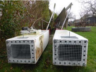
Der Flansch der beiden Rutenhälften der Mühle ‚De Graanhalm‘ mit den Löchern für die 22 Bolzen, mit denen sie zusammengefügt wurden, © Ralf Kreiner 2018.
