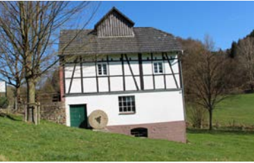
Bruchhauser Mühle in Waldbröl, © Theo Boxberg 2017.
