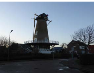
Nach nur vier Jahren mussten bei der Mühle „De Noormann“ in Westkapelle die neuen teilbaren Ruten wieder abgenommen werden, © Ralf Kreiner 2018.
