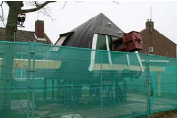
Die aufgebockte neue Haube für die Mühle „De Noormann“ in Westkapelle (Zeeland, NL), 5. Januar 2013, © Ralf Kreiner 2013.
