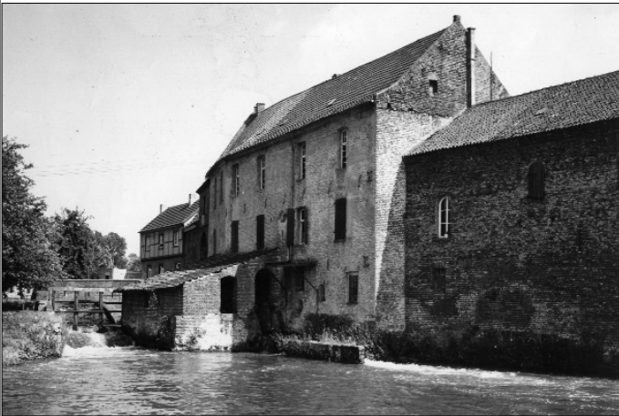
Die Mühle in Bedburg-Kaster verfügte ursprünglich über 3 Mahlgänge, 1 Graupengang und 2 Ölpresen, die von 3 unterschlächtigen Wasserrädern angetrieben wurden. (Foto: Kreisarchiv REK)
