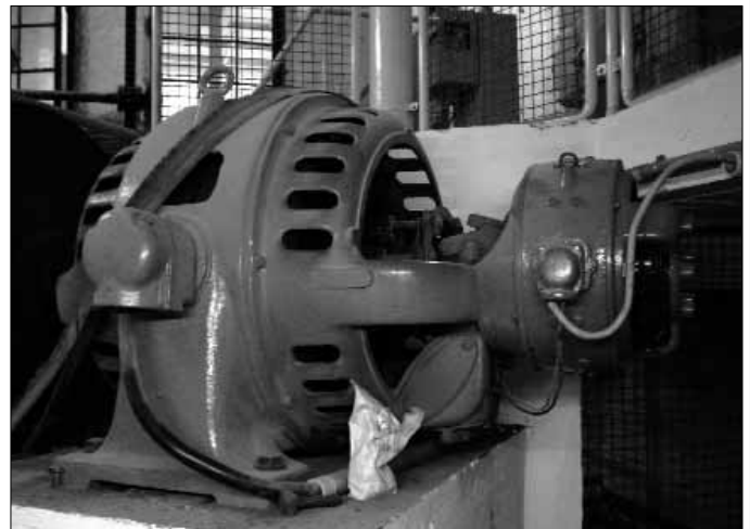
Blick in den 'Kraftraum' der historischen Erprather Mühle.
