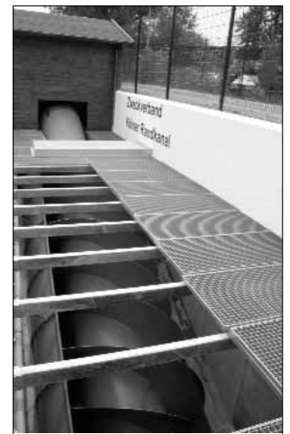
Fische passieren die Wasserschnecke unverletzt.
