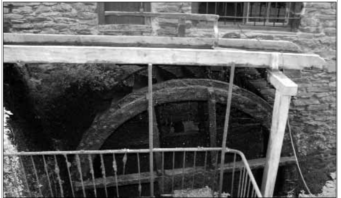
Das oberschlächtige Wasserrad der Mestrenger Mühle
