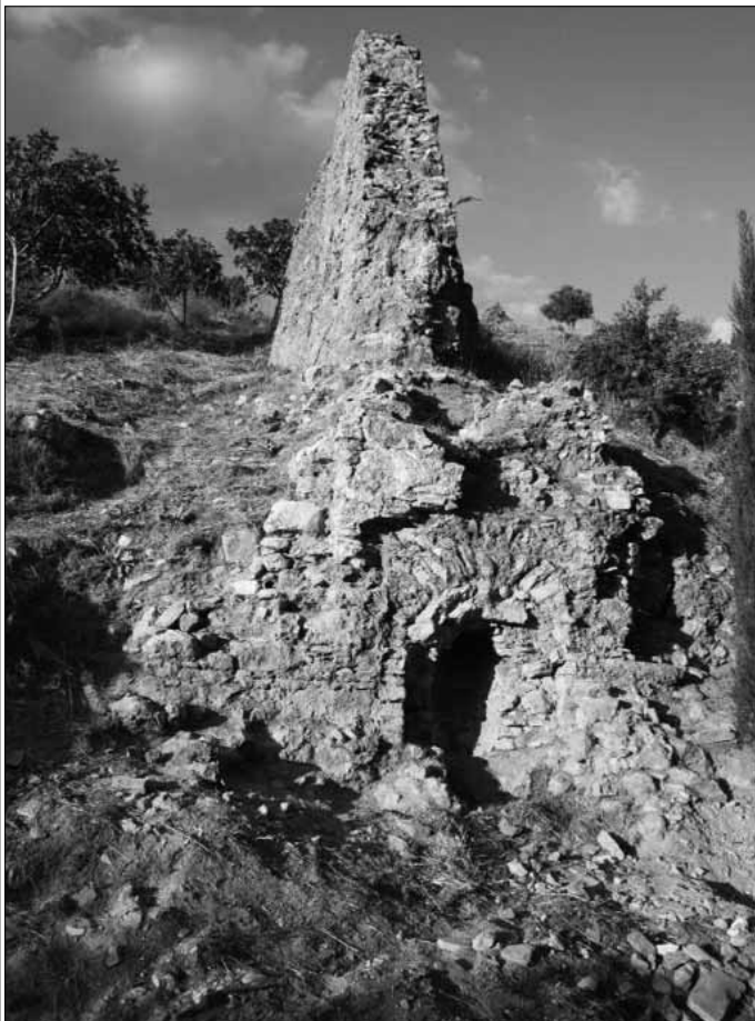
Leitungsmauer (Arubah) und Hangmauer des Mühlhauses von Mühle 4
