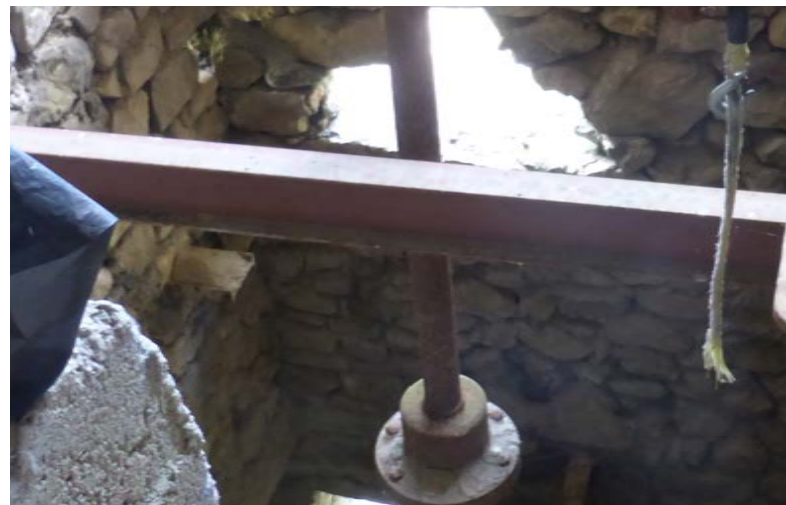
Blick in eine der beiden Radkammern der Moulin des Adams, 2018.
