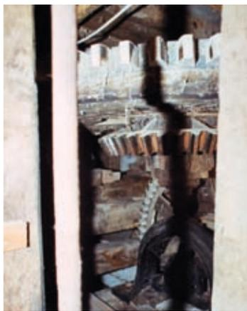
**Bild 4:** Getriebeboden: Stehendes Zeug, Teilansicht
