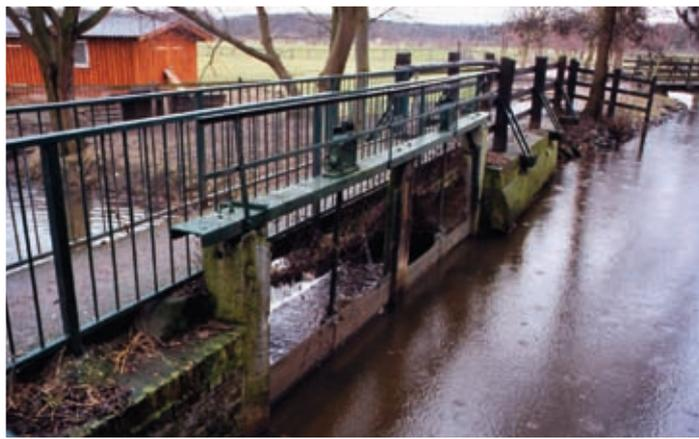
**Bild 18:** Stauschutz: Zulauf / Oberlauf zum Wasserrad
